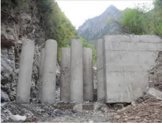
已建支沟桩林坝现状
