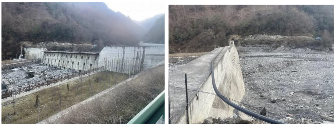
已建主沟拦挡坝现状
