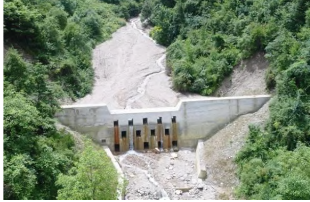
已建支沟拦砂坝现状
